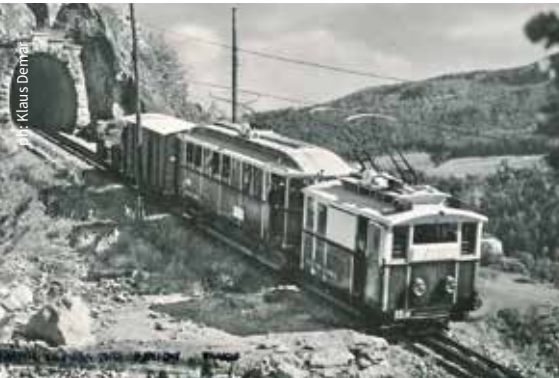
Die Zahnradbahn in den ersten Betriebsjahren
